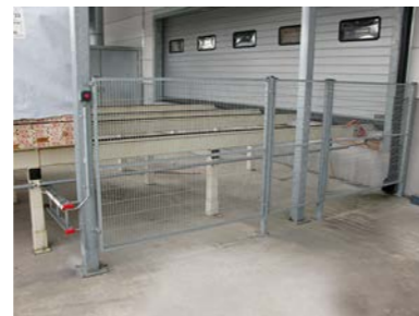
PROTECCIÓN GALVANIZADA Para ambientes al aire libre y húmedos recomendamos paneles y postes galvanizados en caliente.
